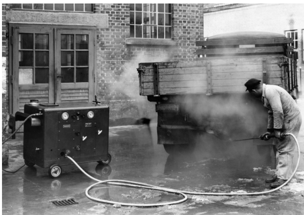
Het allereerste reinigingsapparaat van Kärcher: de eerste Europese KW 350 warmwater hogedrukreiniger uit 1950.
