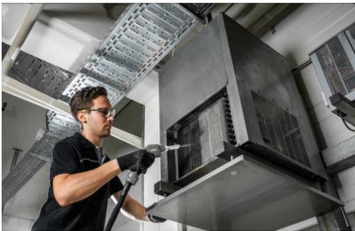
*Nettoyage d'une installation de ventilation industrielle (impureté : poussière, graisse).*
